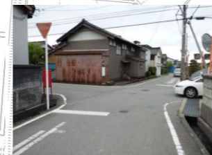
⑨出島地内の道路 見通しが悪い。
